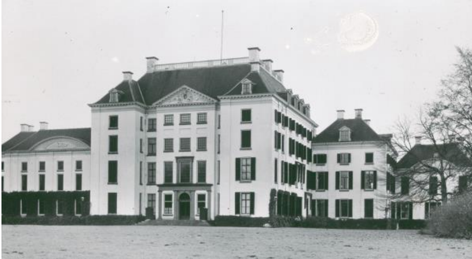
Afbeelding 16: De achterzijde van Het Loo na 1915 na de verbouwing door C.H. Peters. Links bevindt zich de grote balzaal. Ook de beide uitbreidingen (de uitstekende delen) aan het corps de logis zijn goed zichtbaar, evenals het grijswit bepleisterde uiterlijk. Bron: J.F. Dröge, Bouwhistorisch onderzoek. Paleis Het Loo. Deel 1. Algemeen (Leiden 2015) 50.
