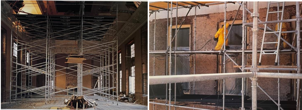
Afbeeldingen 27 en 28: Links de ontmanteling van de grote balzaal. Rechts het ontleisteren van het westelijk paviljoen. Bron: Adriaan W. Vliegthart, Het Loo. Een paleis als museum (Apeldoorn 1999) 39 en 40.
